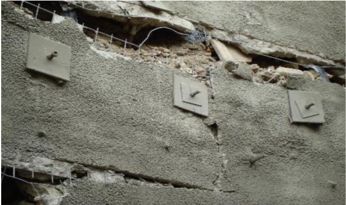
گسیخته شدن دیوار میخکوبی شده در خاک بدون چسبندگی
