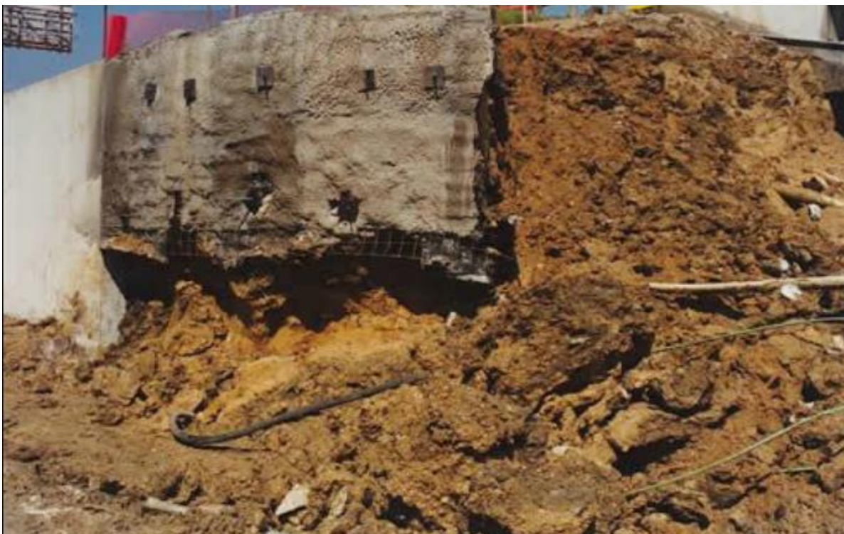
گسیخته شدن دیوار میخکوبی شده در خاک رس نرم
